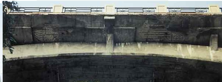
2. Der Korrosionsschutz wandert durch den Beton und wird vom Stahl wie von einem Magneten angezogen.
